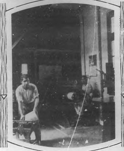
Departamento de esterotipa, donde confeccionan las planchas para la máquina rotativa. Eustaquio Pedrosa, esterotipador, preparando una plancha en la máquina rebajadora.
